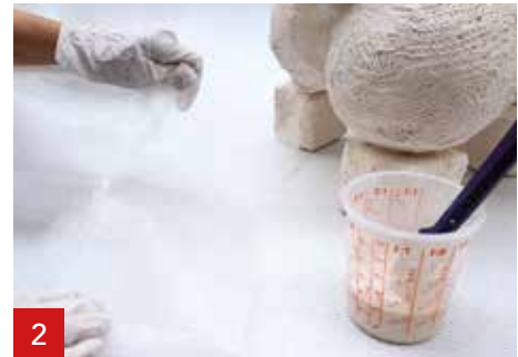
2 Scheur stukjes C-vlies af (gebruik handschoenen).
