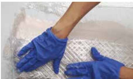
8 ...en druk een tweede laag A1 Triaxial glass fibre in de nog natte A1.
