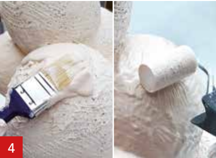
4 De A1 kan worden opgebracht met een kwast, roller, spatel of wisser.
