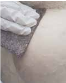
7 Of gebruik (na ong. 20 minuten) een vochtige spons of een waterproof schuurpad.
